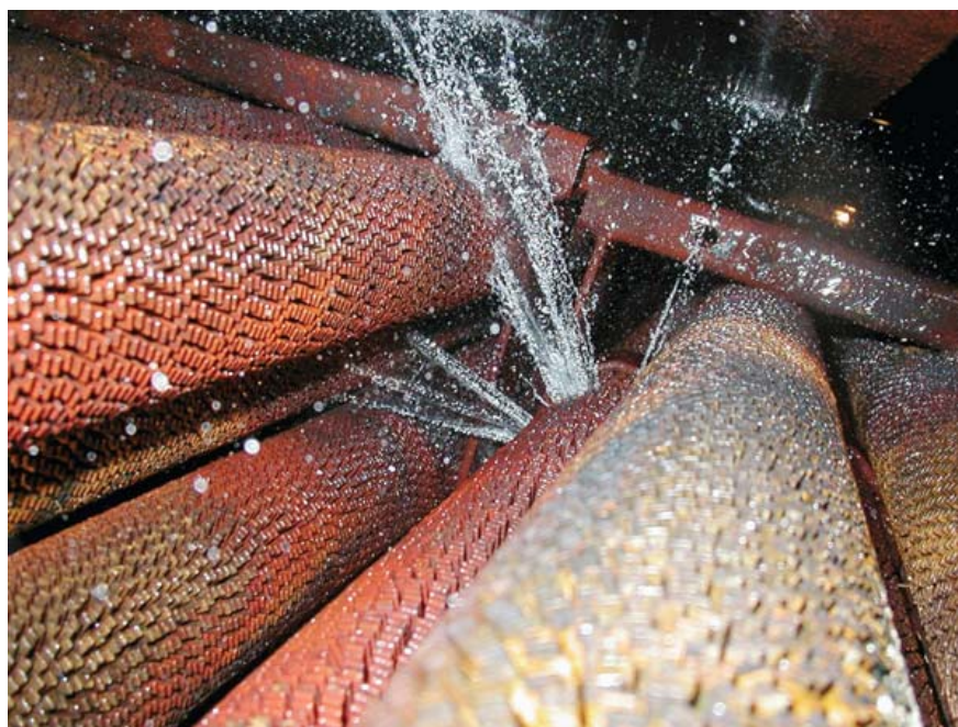
عکس اکونومایزر خوردگی و نشتی در اکونومایزر
